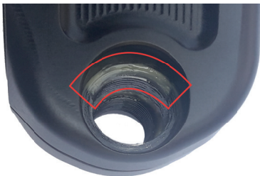
Abb.1: Fettdepot in der Schraubensenkung
